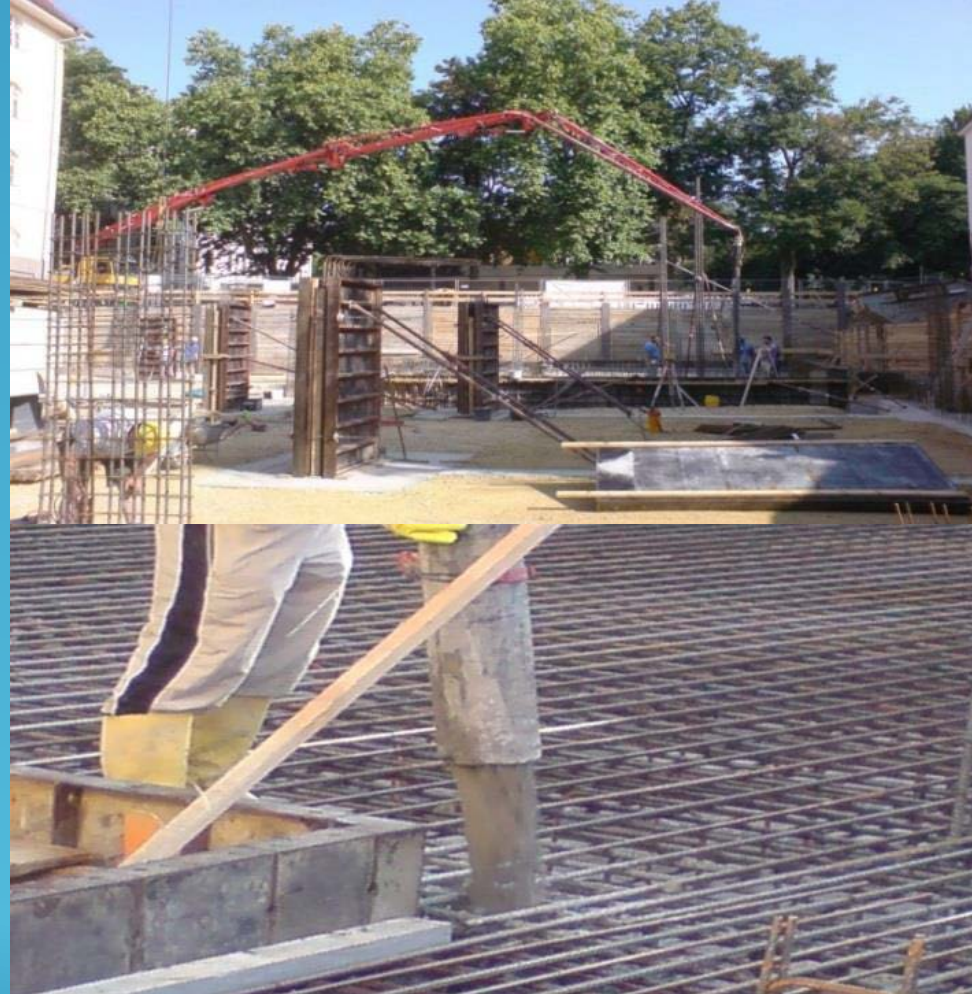
Beton pompasi ile dokum
