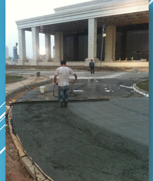
Titresimli master yardimi ile beton tesviyesi
