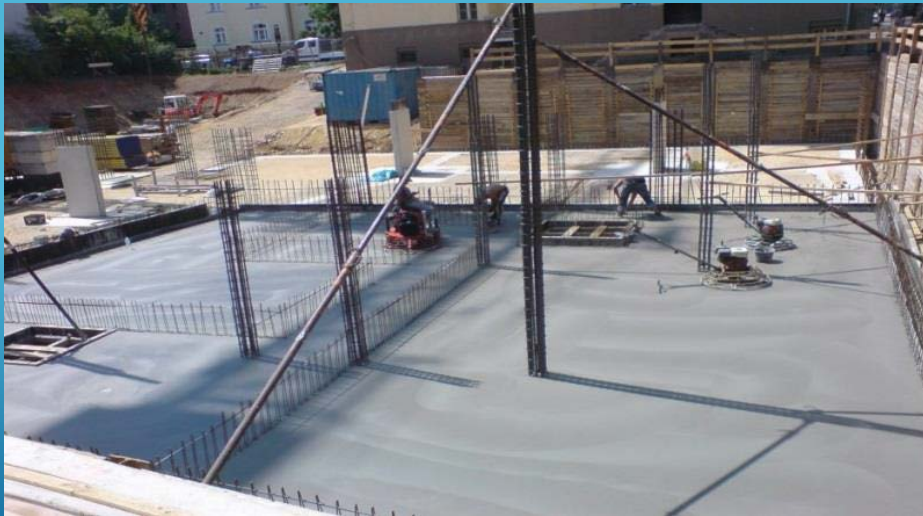
Helikopter yardımı ile zeminin perdahlanması.
