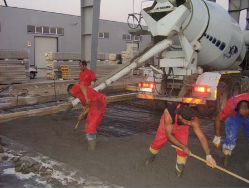
Mixer ile ve lazerli beton dokumu
