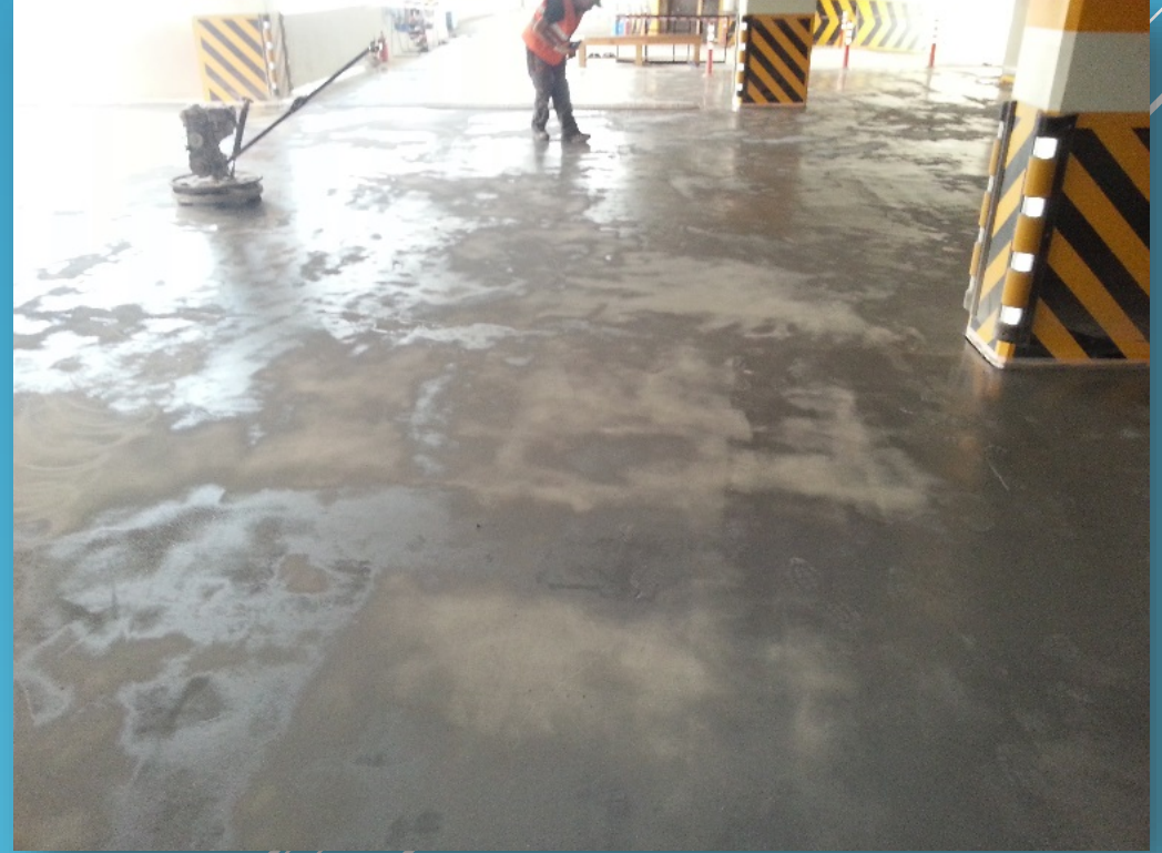
Birinci kat epoxy uygulanması ve kumlama yapılması.
