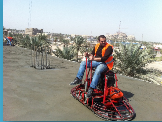
Helikopter yardımı ile zeminin perdahlanması.
