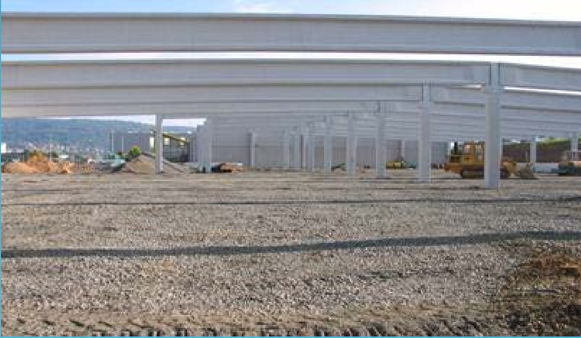
Saha betonu için hazirlanan saha
