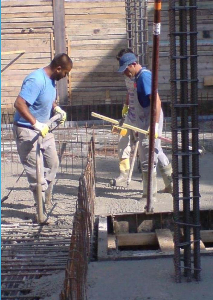
Vibrasyon ve lazer ile beton dokumu
