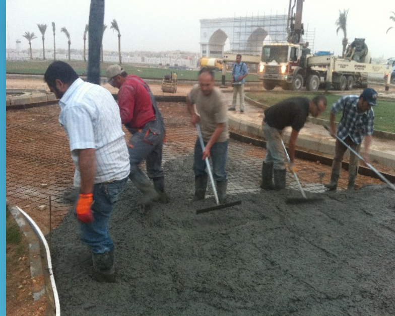
Beton pompasi ve lazer ile beton dokumu
