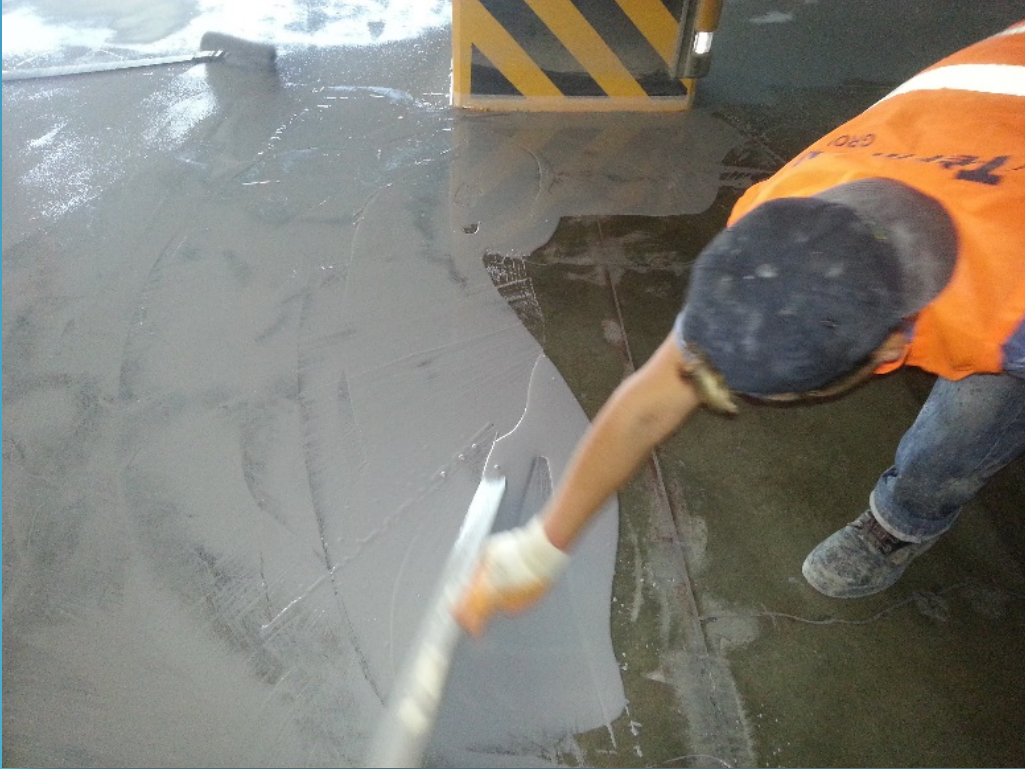
Birinci kat epoxy uygulanması ve kumlama yapılması.
