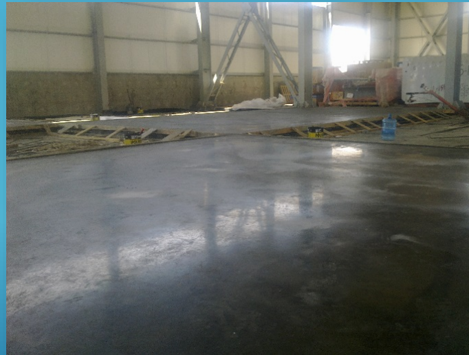
Helikopter yardımı ile zeminin perdahlanması.
