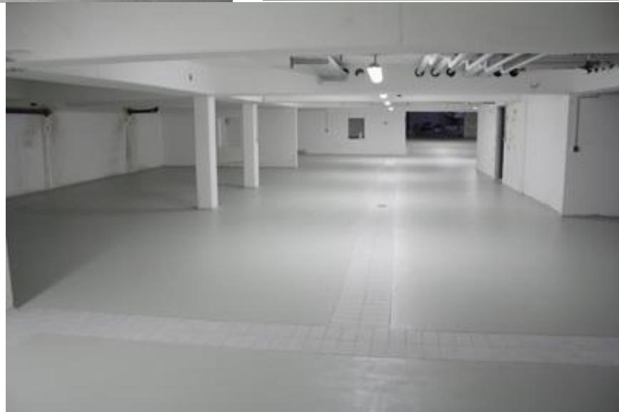
Impermeabilizarea are o grosime a stratului de 0,1 – 0,3 mm si are dezavantajul ca nu pot fi nivellate denivelarile. Din aceasta cauza baza trebuie slefuita, aspirata si data cu grund. Pentru aspectul optic se ofera impermeabilizari colorate in diferite nuante standard, contra cost, si pot fi procurate aproape in toate nuantele - RAL.
