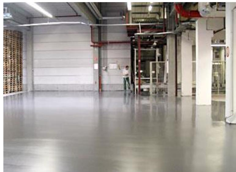
Impregnarea va fi folosita in intreprinderile industriale si spatiile comerciale, in halele de depozitare, garaje si partial la constructia locuintelor pentru spatiile – pivnita. Pentru a obtine o impregnare de durata se ajunge la o adancime ridicata de penetrare.
